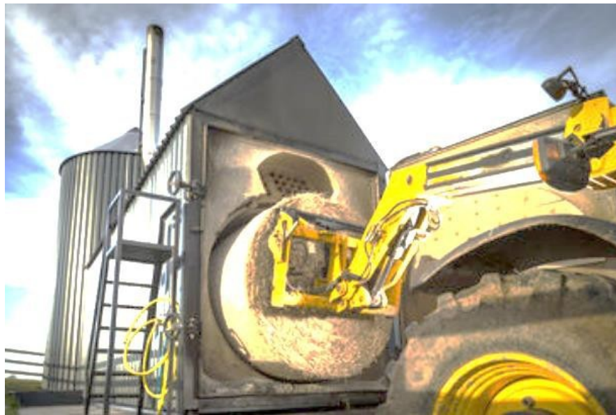
Рисунок 4.4 – Завантаження бункера міні-ТЕЦ соломою
