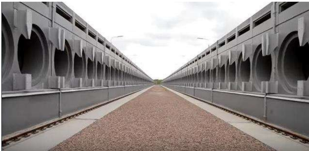
Рисунок 4.13 – Сховище ВЯП за технологією сухого модульного зберігання (СЗВЯП-2) на території ЧАЕС
